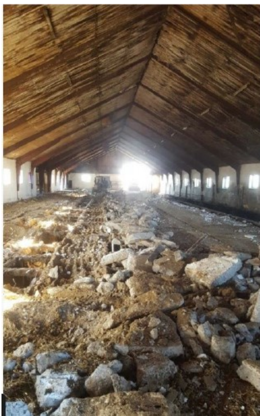
Figur 4. Tilsagnshaver dokumenterer at gulvet er brudt op gennem egne fotos af projektet fra start. Fotos lånt ud til Lotte Ørbæk Andersen (LBST).
